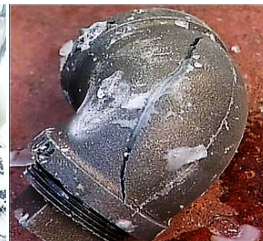
Рис. 4. Разрушение переходника Fig. 4. Destruction of the adapter
