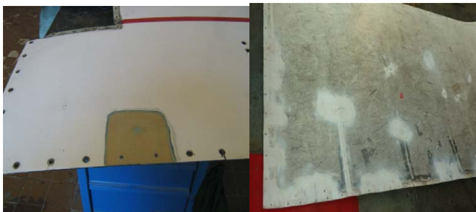
Рис. 1. Разрушения багажного отсека на самолетах Боинг
